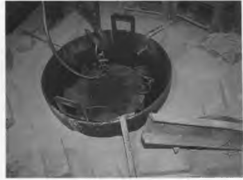
Рис. 3. Механизированная набивка футеровки тигля индукционной печи HFD-4 СПО ЦПМ
